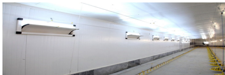
(نمایی از اینلت نصب شده در سالن پرورش جوجه های گوشتی)
